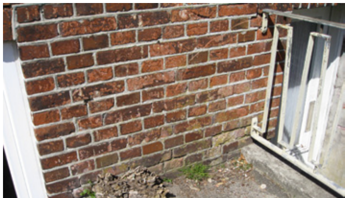
Eksempel på manglende sokkel og nedslidt murværk (Borgergade 1B)
