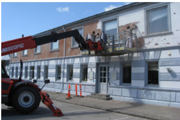
Igangværende renovering af facaden på Bundgaards Hotel.
