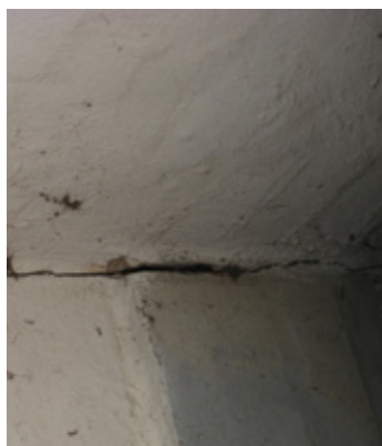
Eksempler på sætningsskader (hotellet, den del, der vender ud mod Borbergade)
