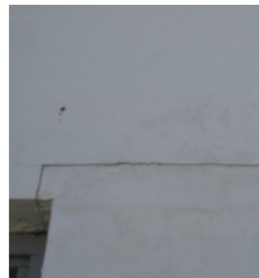
Eksempler på sætningsskader (hotellet, den del, der vender ud mod Borbergade)
