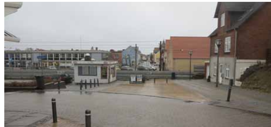
Nørregades afslutning. Banen med støjskærmen mod banelegemet.
