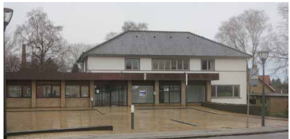
Tidligere Nordea bankfilial - nu en tom bygning. Udnyttelse ?
