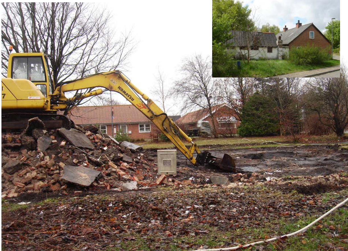
"Bordellet" før og efter nedrivning
