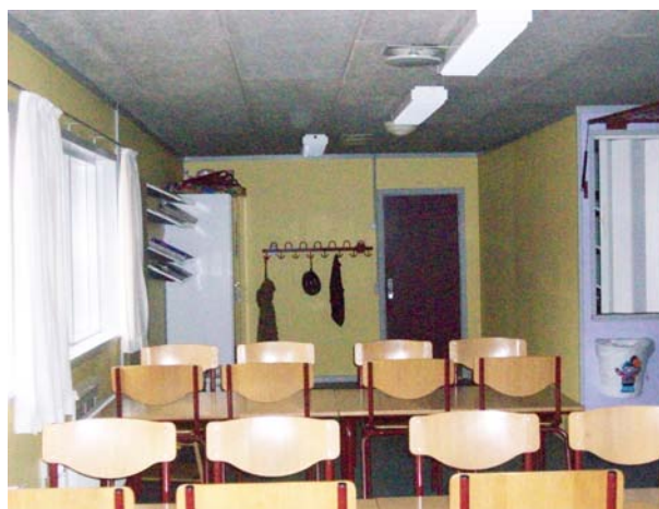
Hallens nuværende cafeteria ønskes bygget om
