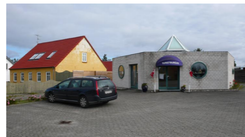
Bygningen, der rummer turistkontoret, falder helt uden for det øvrige bybillede.
