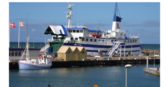
Vesterø Havn er som færgehavn "livlinen" til fastlandet og samtidig "dørtrinnet" til Læsø.
